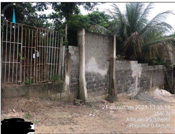
Figura 9 Lote para implantação da EEEB P04
