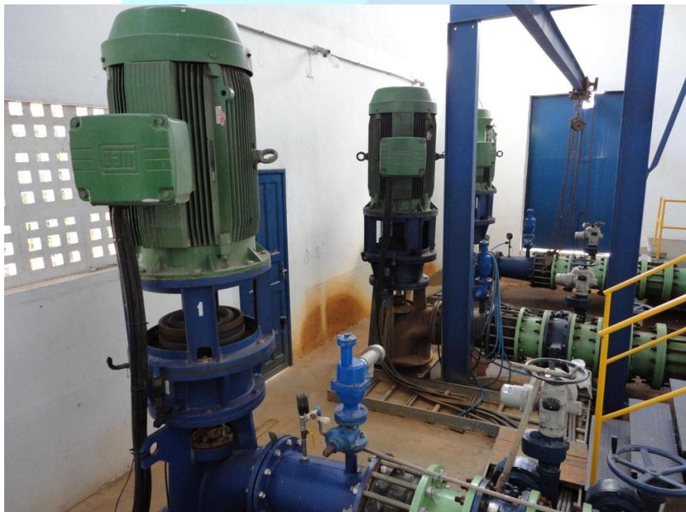
Captação 3 motores de 400 CV
