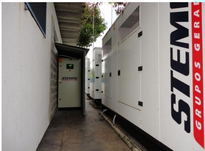
Painel de transferência automático responsável pela seleção entre subestação e unidade geradora.
