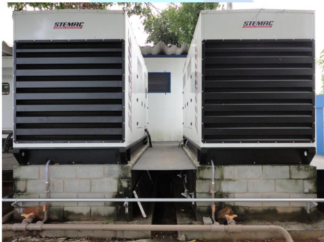
Geradores Síncronos de 500 kVA, 440/254 V, 1800 rpm, 60 Hz.
