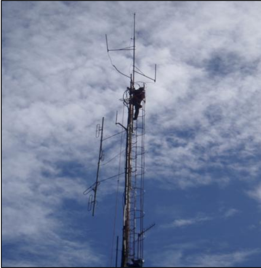
Antenas de Transmissão por Comando de Telemetria a serem substituídas
