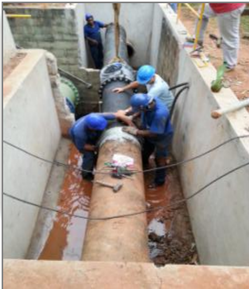
Instalação do macromedidor da adutora DN500 de Castelo Branco – ETA I – Vale Esperança
