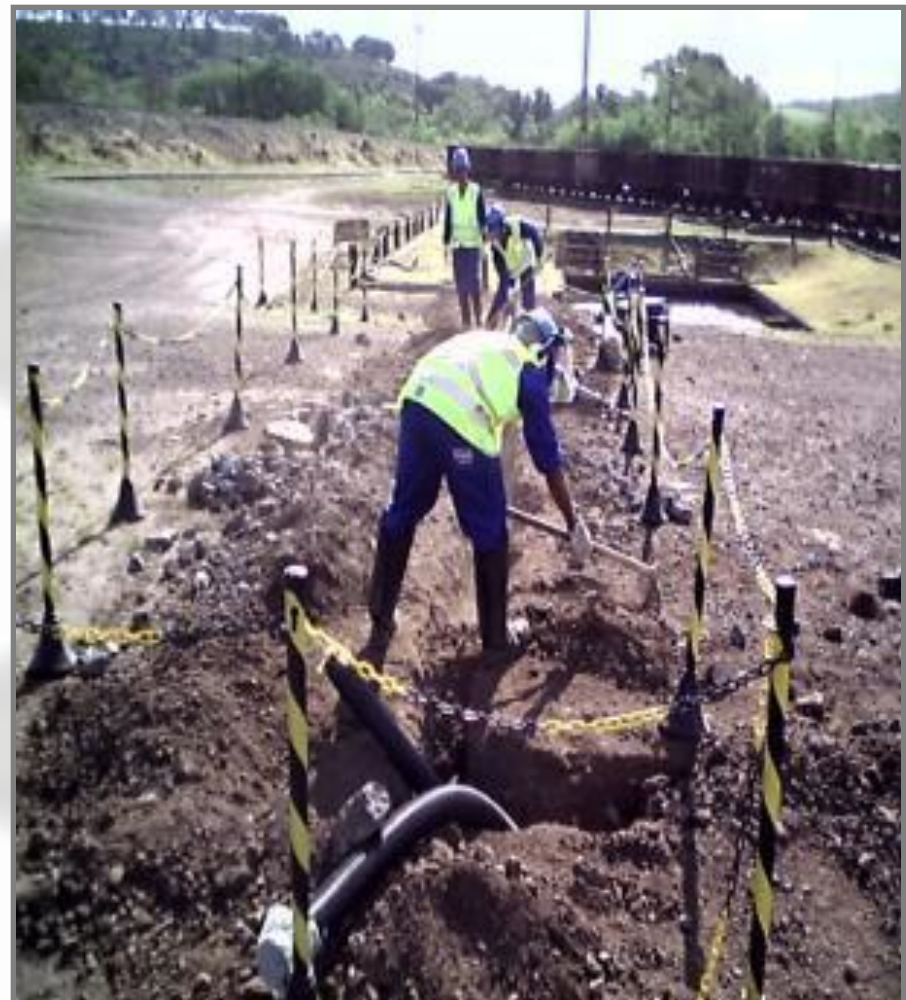
Escavação do solo para lançamento de canaflex, cabo de controle e força.
