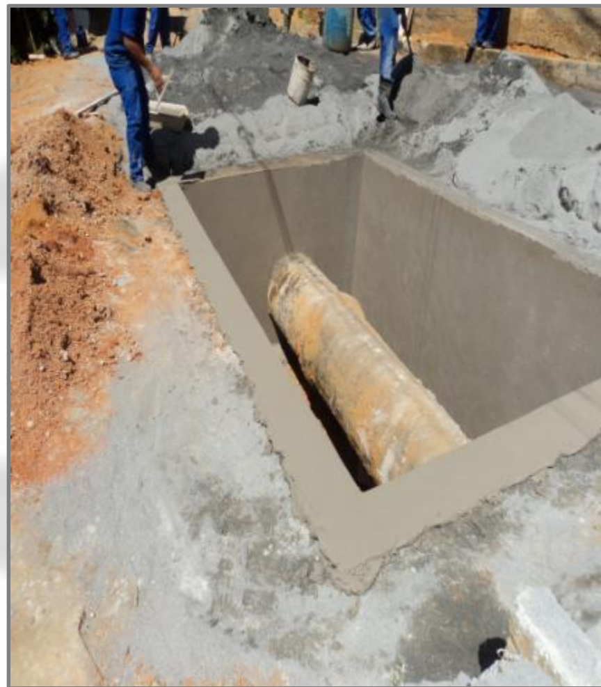
Construção da caixa de abrigo do macromedidor de Campo Grande DN700
