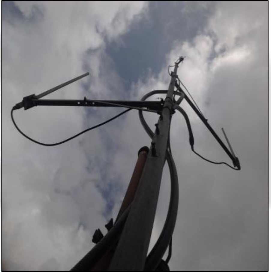
Antenas de Transmissão por Comando de Telemetria a serem substituídas
