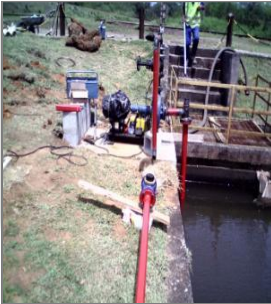
Montagem do conjunto moto-bomba (hidrômetro, manômetro, válvula globo, junta de expansão, registro)
