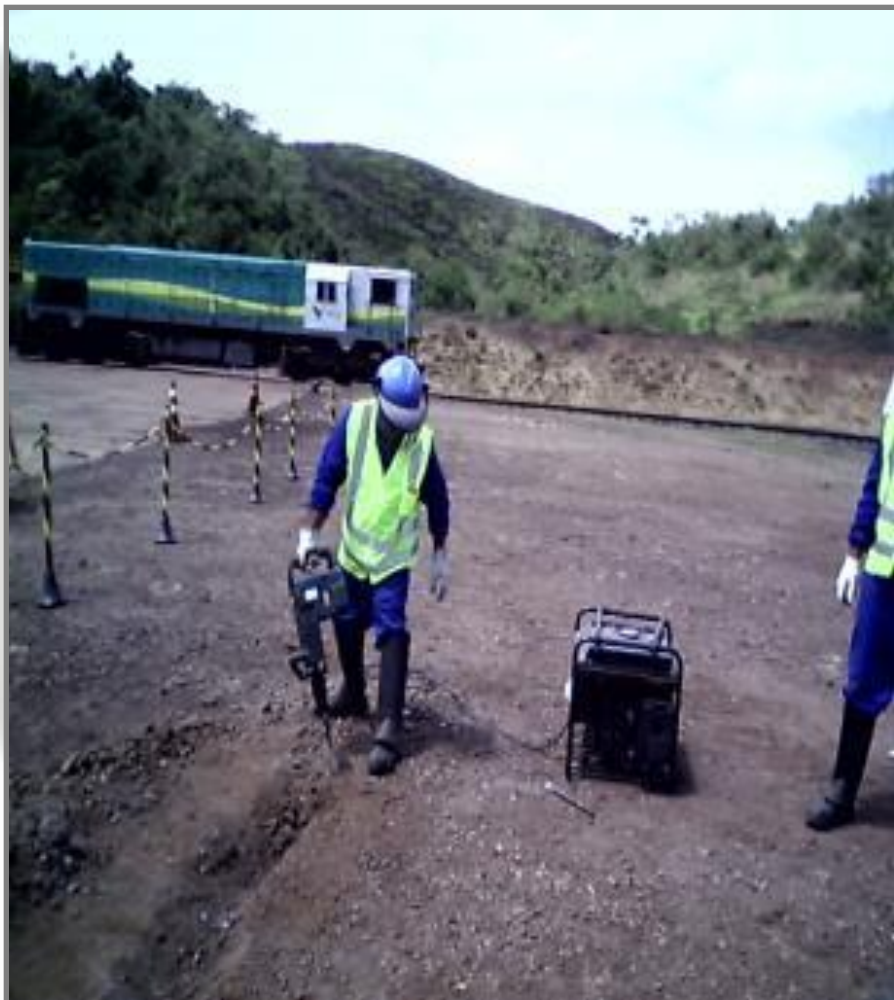
Escavação do solo para lançamento de canaflex, cabo de controle e força.
