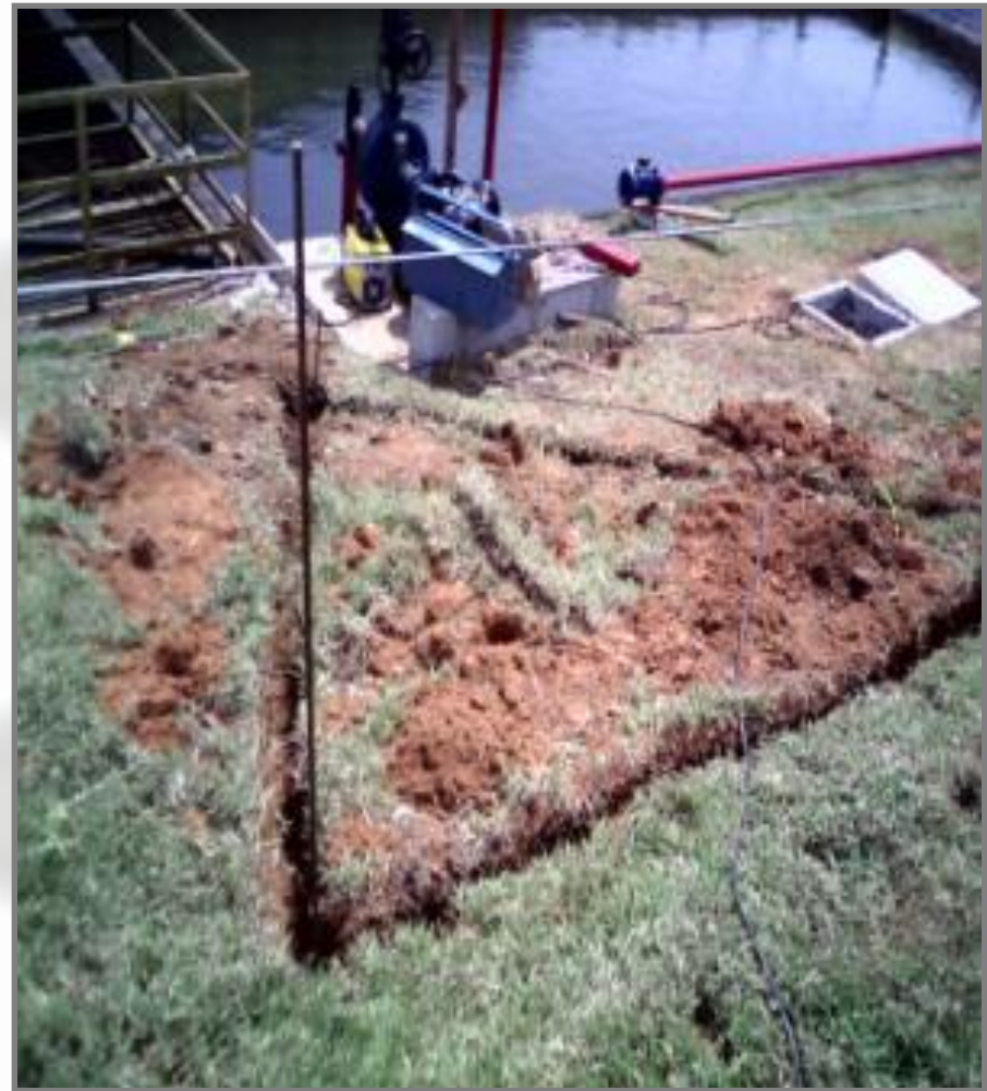
Aterramento do Conjunto Moto-bomba
