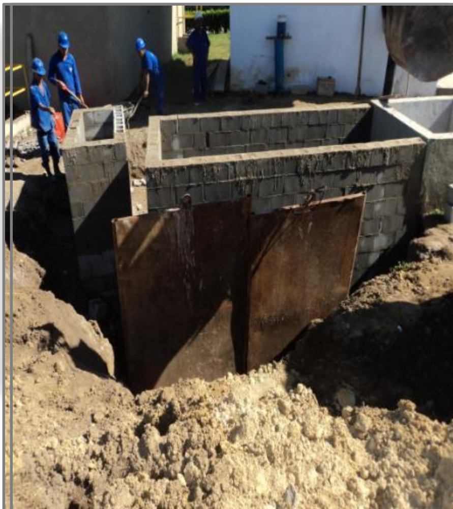
Construção da caixa de abrigo do macromedidor de Santa Maria DN 300 p/ 250mm
