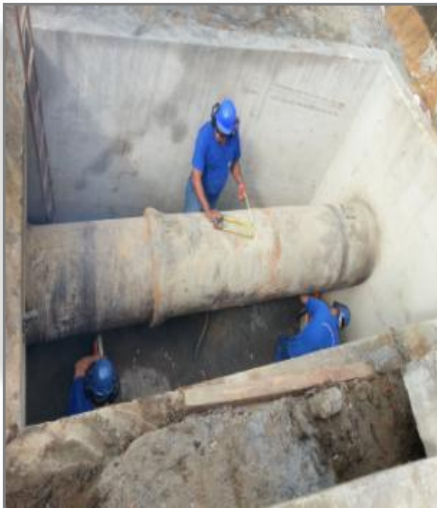
Retirada de parte da tubulação DN700 existente para instalação do macromedidor de Campo Grande
