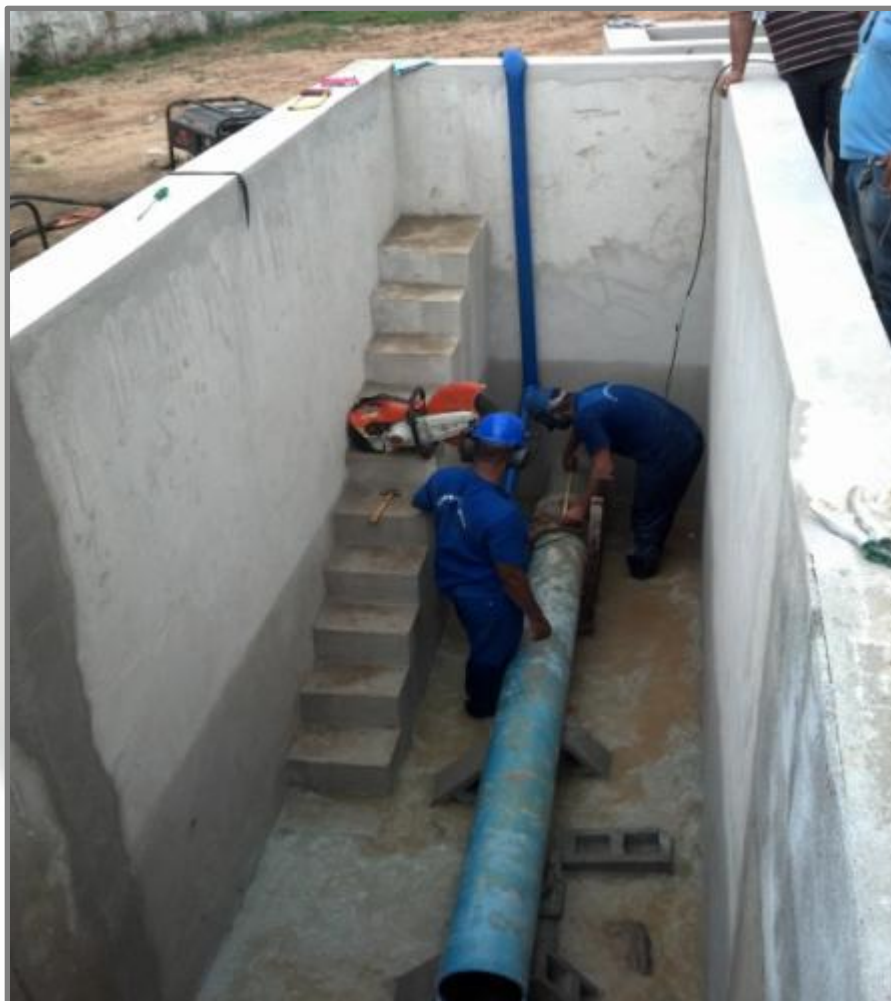
Instalação do macromedidor de Santa Maria DN 300 p/ 250mm
