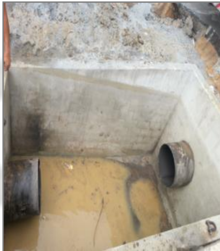
Retirada de parte da tubulação DN700 existente para instalação do macromedidor de Campo Grande
