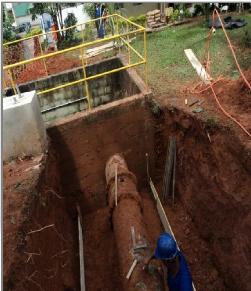
Construção da caixa de abrigo do macromedidor de Castelo Branco DN500 – ETA I – Vale Esperança
