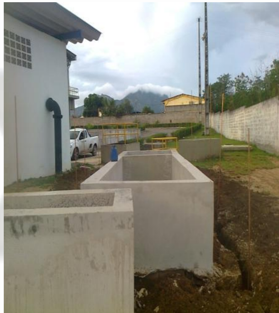
Construção da caixa de abrigo do macromedidor de Santa Maria DN 300 p/ 250mm
