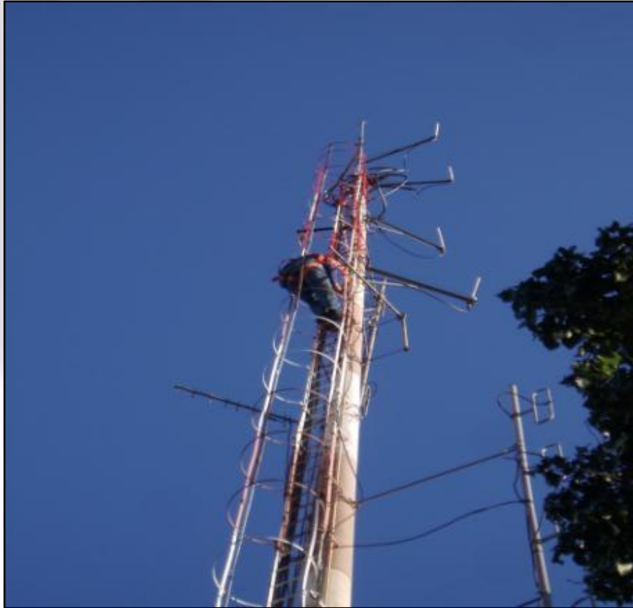
Substituição das Antenas e recuperação da Pintura da Escada Marinheiro de Acesso
