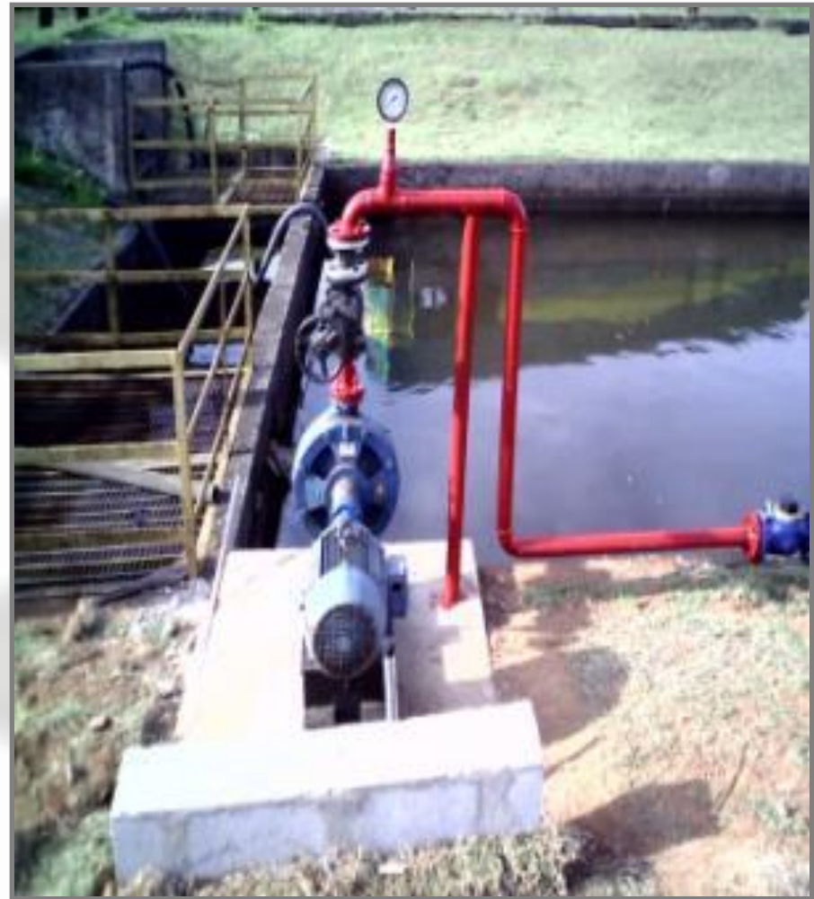
Montagem do conjunto moto-bomba (hidrômetro, manômetro, válvula globo, junta de expansão, registro)
