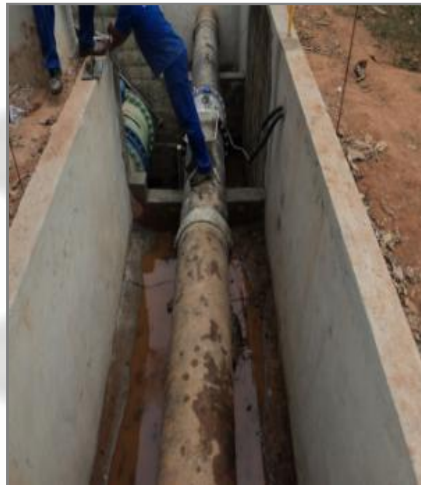
Instalação do macromedidor da adutora DN500 de Castelo Branco – ETA I – Vale Esperança
