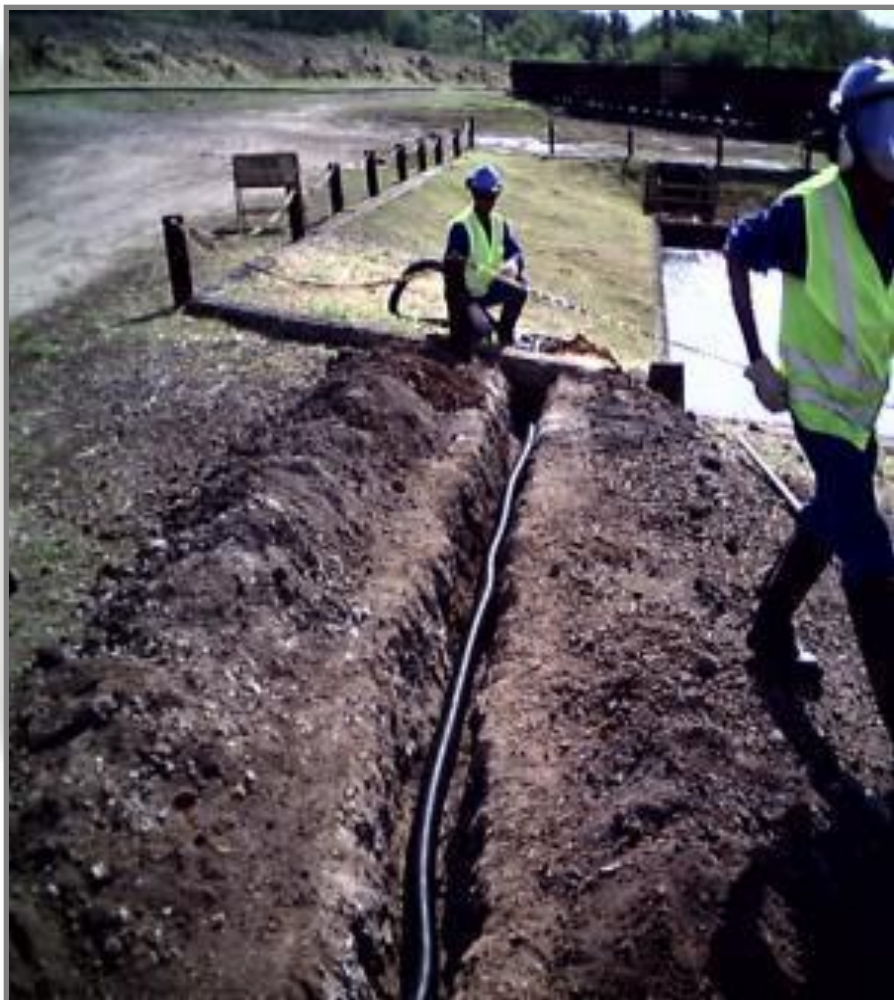
Lançamento de canaflex, e montagem da tubulação de recalque
