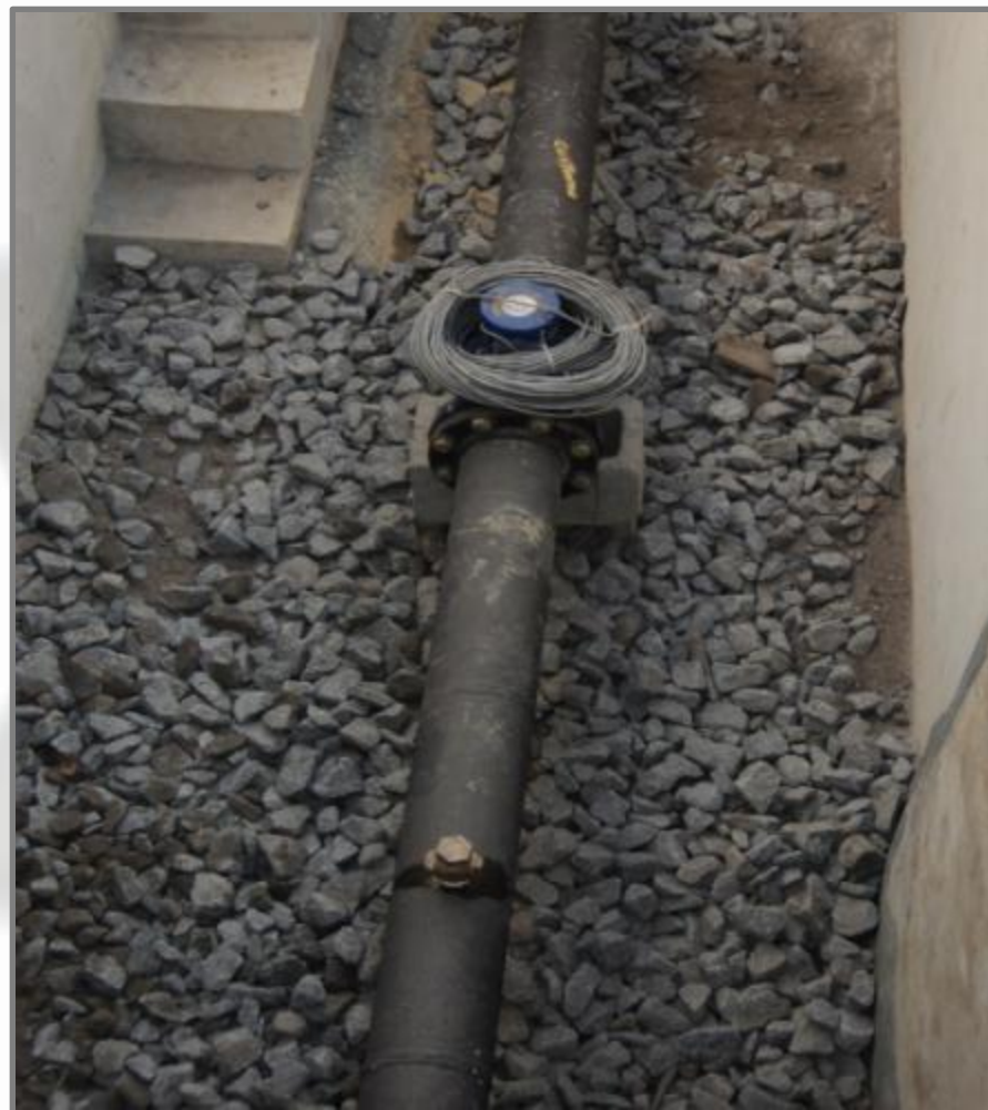
Instalação do macromedidor de Santa Maria DN 300 p/ 250mm
