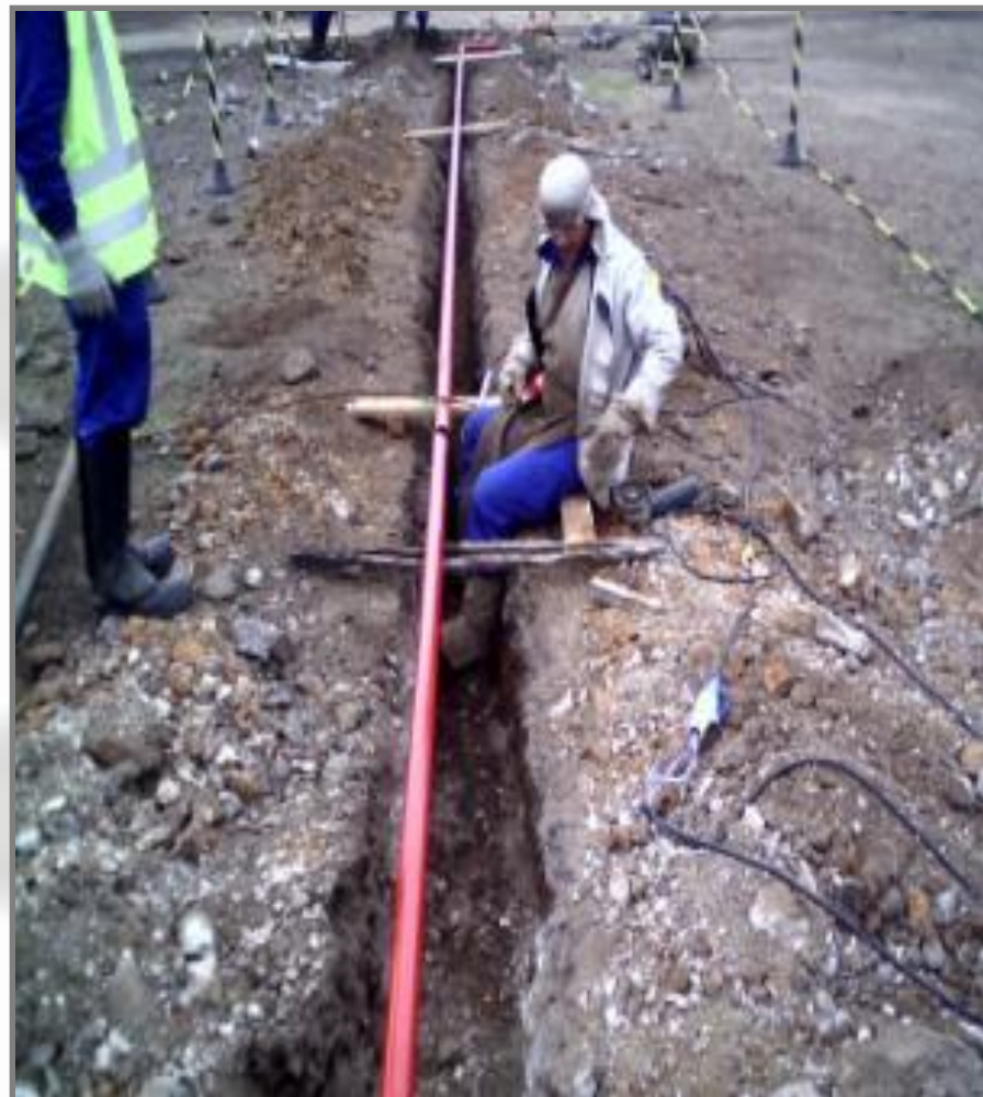
Lançamento de canaflex, e montagem da tubulação de recalque
