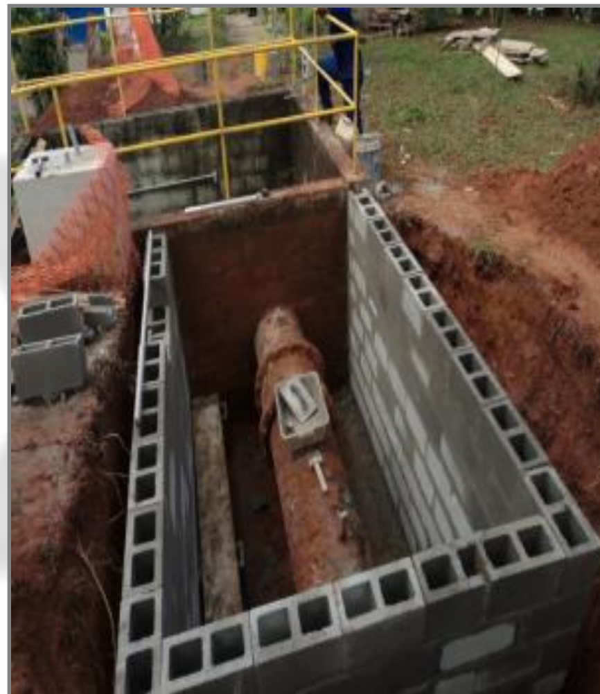
Construção da caixa de abrigo do macromedidor de Castelo Branco DN500 – ETA I – Vale Esperança
