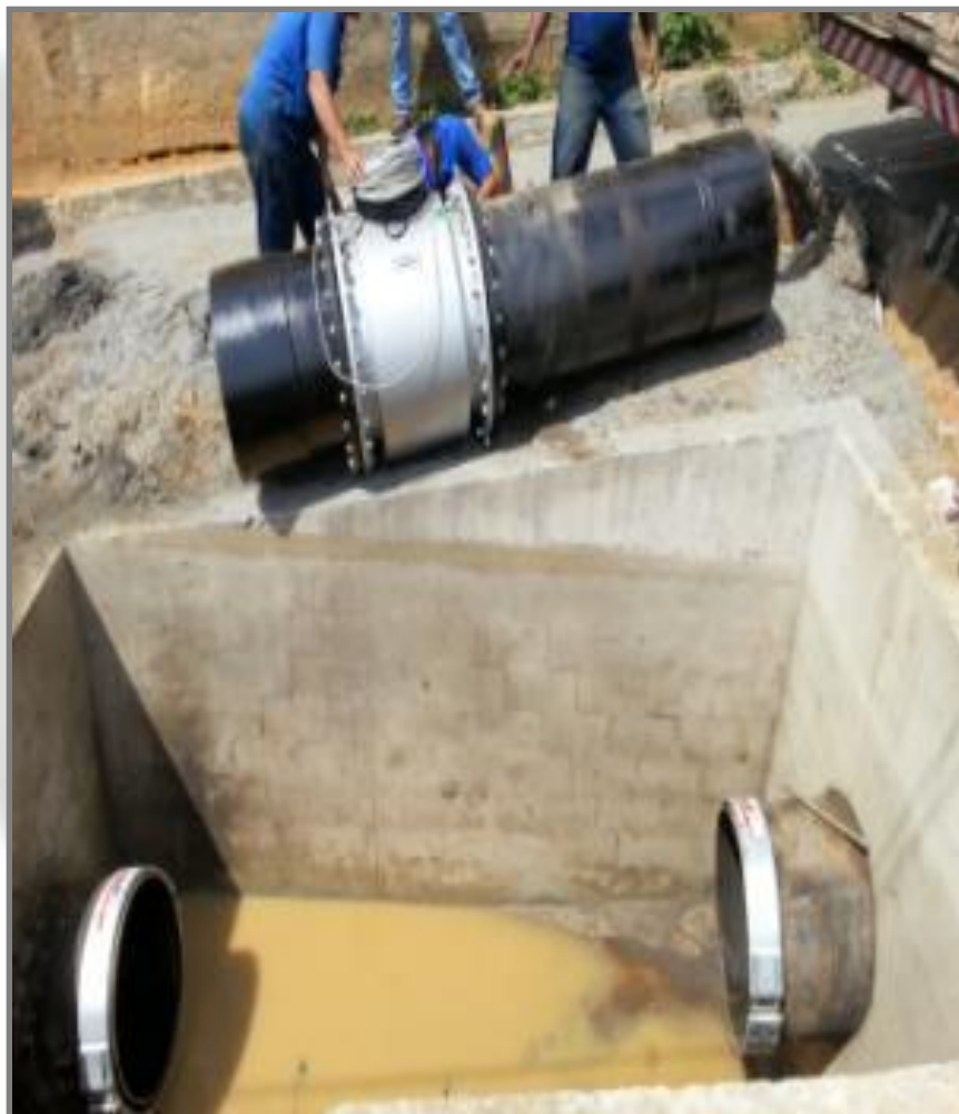
Instalação do macromedidor na adutora de Campo Grande DN700mm
