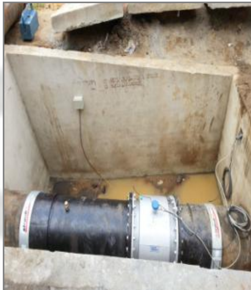
Instalação do macromedidor na adutora de Campo Grande DN700mm
