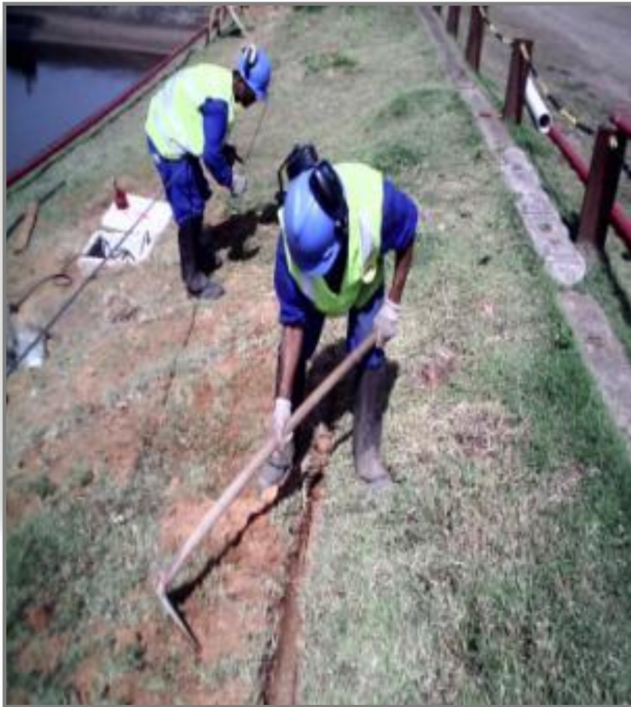
Aterramento do Conjunto Moto-bomba
