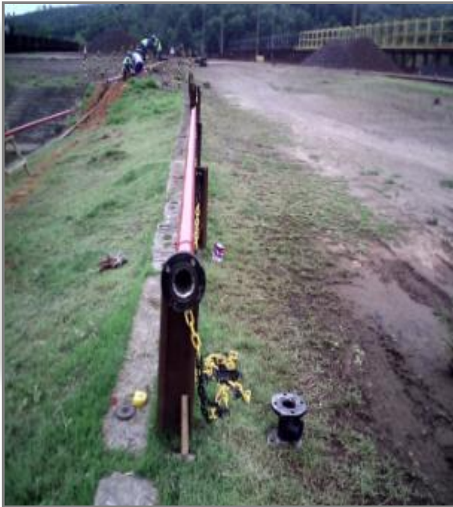
Montagem da tubulação de recalque
