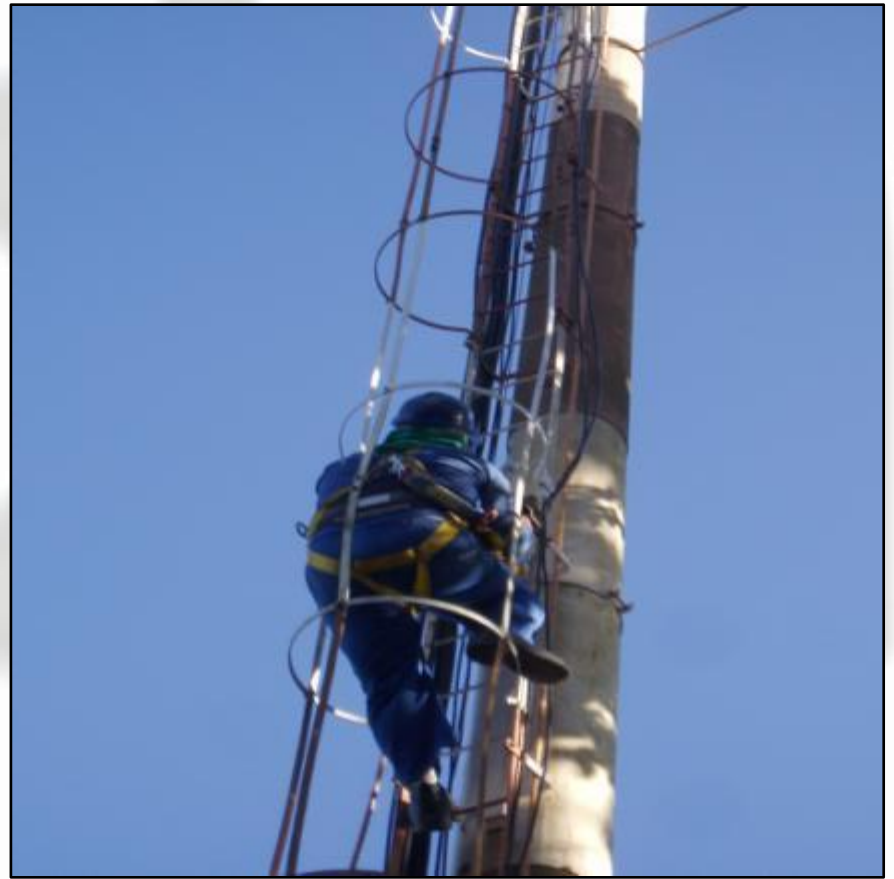
Substituição das Antenas e recuperação da Pintura da Escada Marinheiro de Acesso
