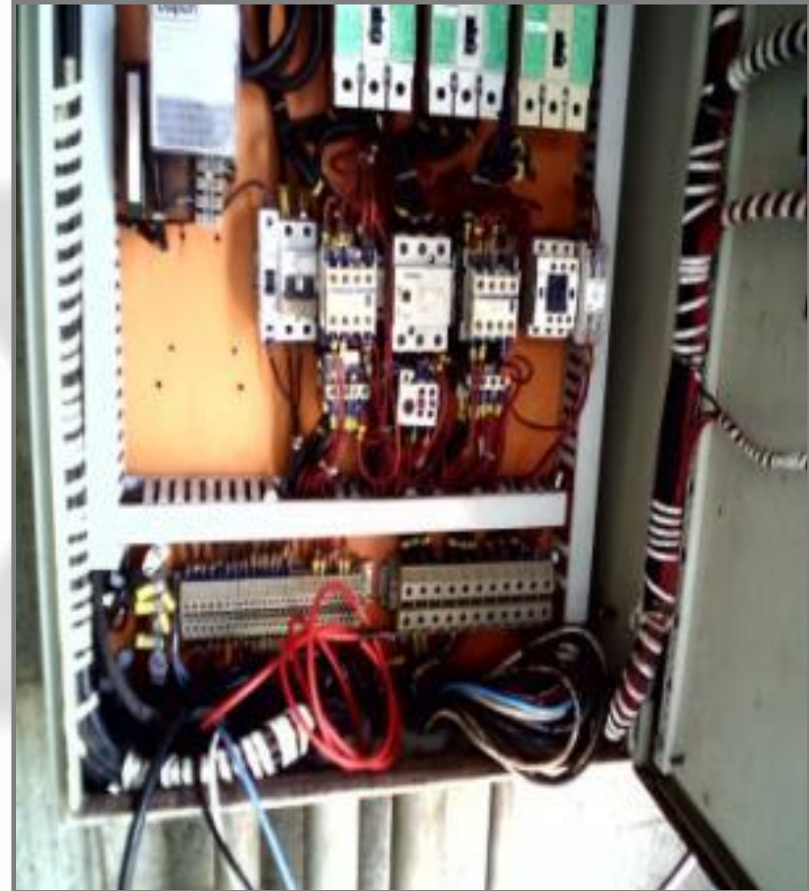
Limpeza e manutenção do painel de força/comando do conjunto moto-bomba
