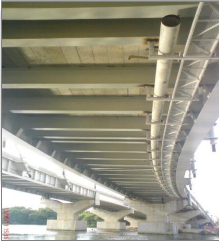
Fabricação/Montagem de estruturas, guarda corpo e tubulação sob a Ponte da Passagem - Vitória
