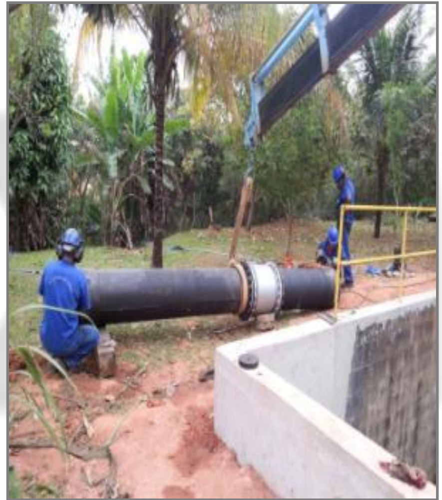
Instalação do macromedidor da adutora DN500 de Castelo Branco – ETA I – Vale Esperança
