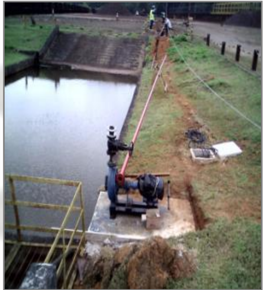
Montagem da tubulação de recalque
