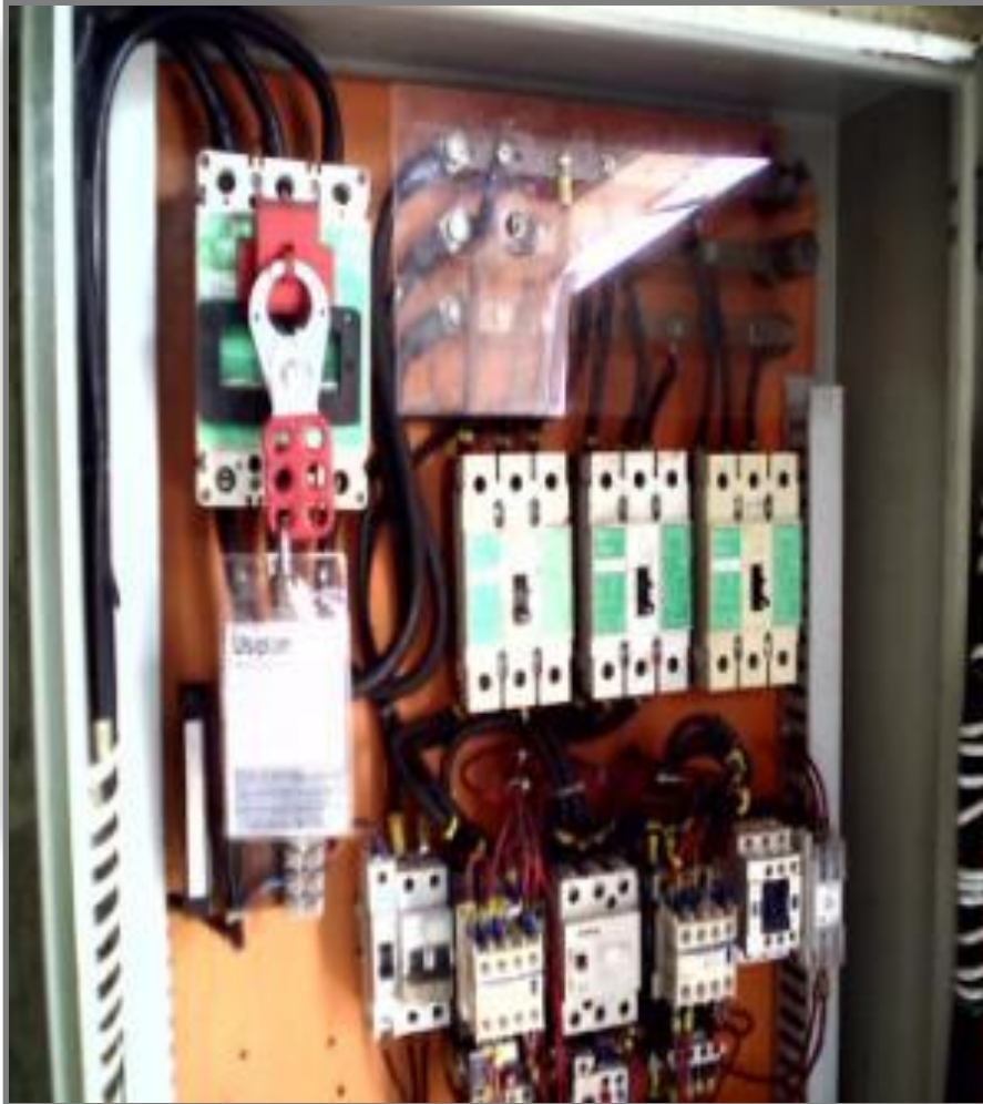
Limpeza e manutenção do painel de força/comando do conjunto moto-bomba
