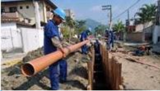
EXECUÇÃO DA OBRA
